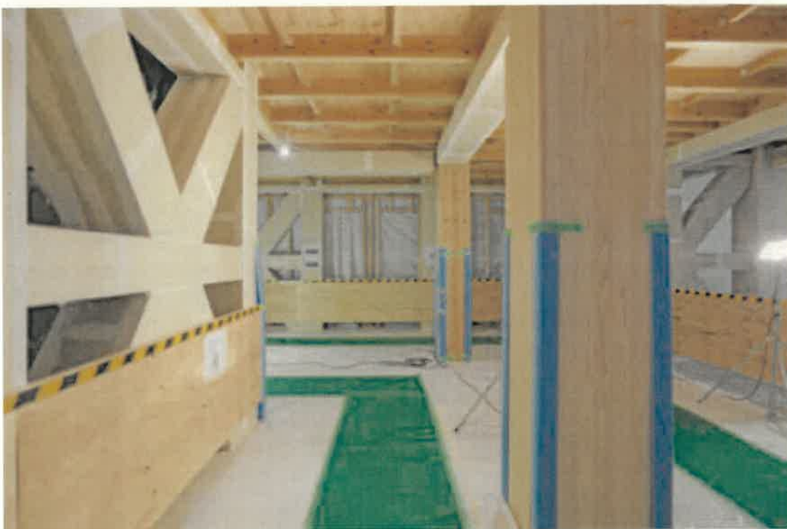
※工事中の写真
