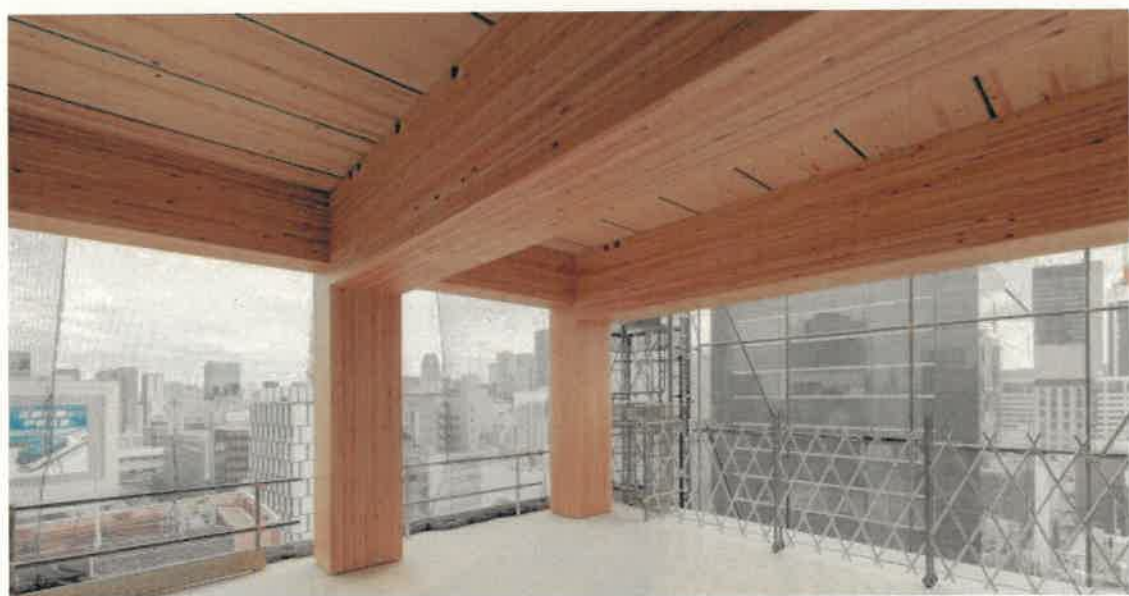
※工事中の写真
