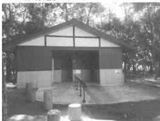
県有施設（トイレ）の改修
