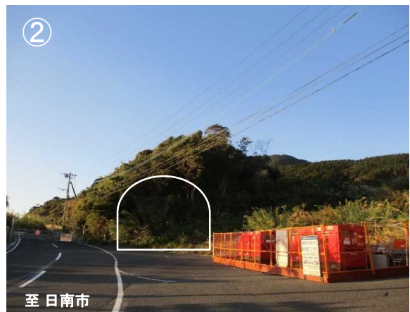
トンネル坑口(近景)
