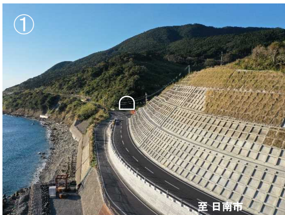
トンネル坑口(遠景)
