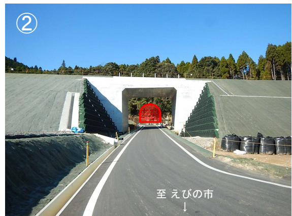
トンネル坑口(近景)
