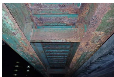
橋梁下面の劣化状況
