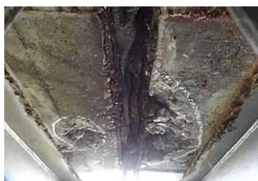
橋梁下面の劣化状況
