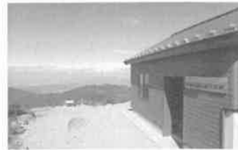
4-(1) 霧島錦江湾国立公園 韓国岳休憩所整備
