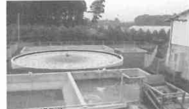
2-(1) 汚水処理施設
