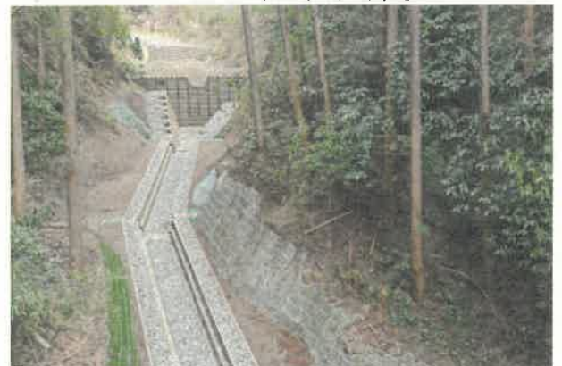
林地荒廃防止事業(都城市山田町山田) 木製治山ダム(校倉式床固工)
