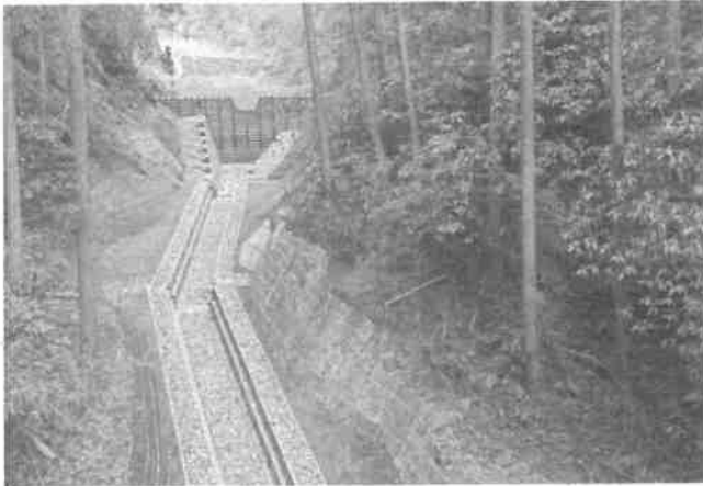
林地荒廃防止事業(都城市山田町山田) 木製治山ダム(校倉式床固工)
