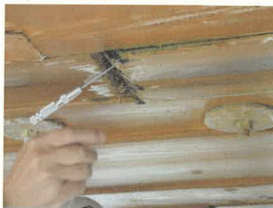
写真2 ドライバーによる触診点検
