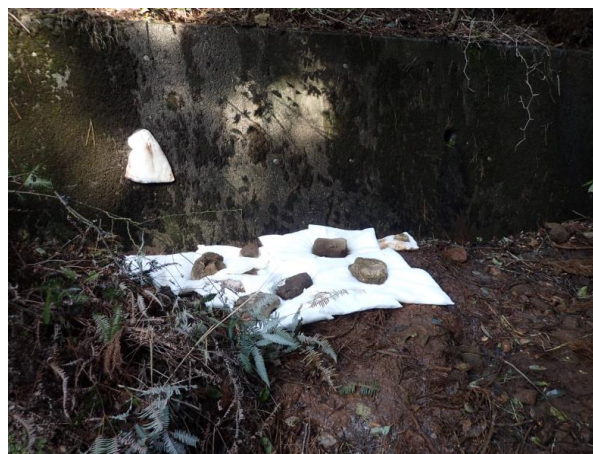
図2 吸水シートの敷設
