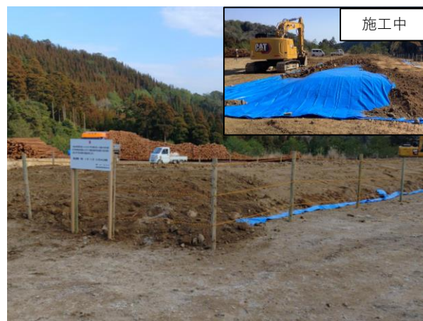
図4 埋却溝への雨水浸透防止シート敷設
