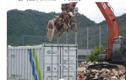
【仮置場の処理②】
