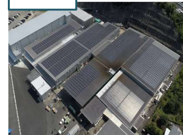
(例)屋根に設置した太陽光パネル
