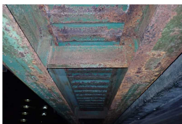
橋梁下面の劣化状況
