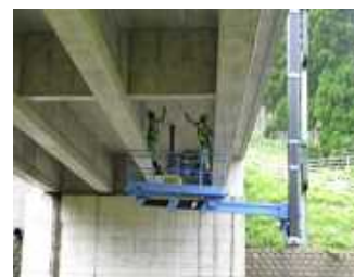
橋梁点検状況
