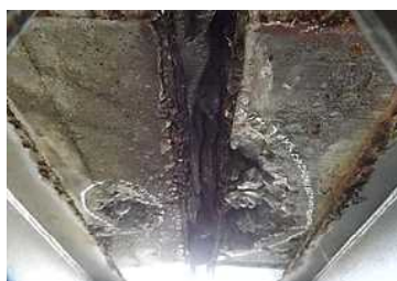
橋梁下面の劣化状況
