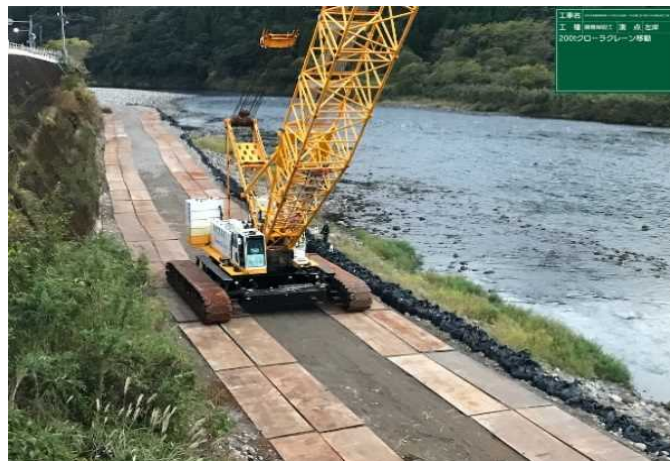
【クレーン移動状況】
