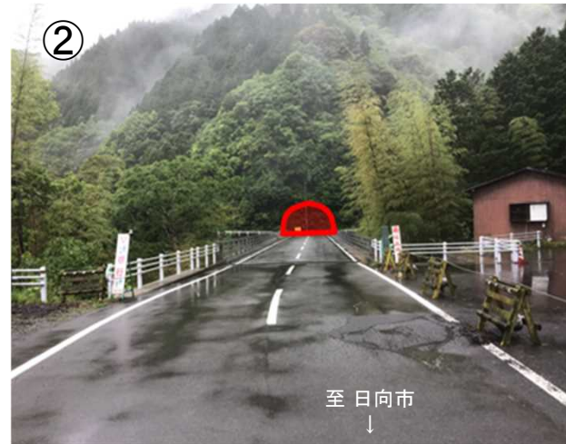
トンネル坑口 (日向市側)
