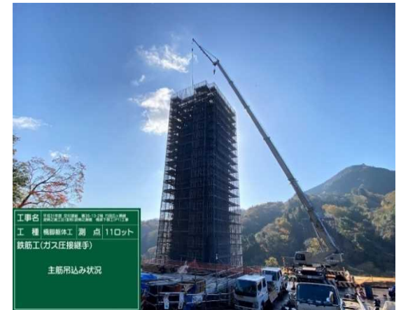
50t吊りクレーン 使用状況
