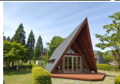
ひなもり台県民ふれあいの森 ひなたキャビン（管理運営）
