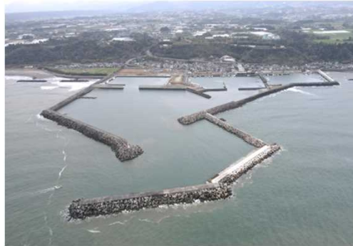
図18 防波堤の整備（川南漁港）
