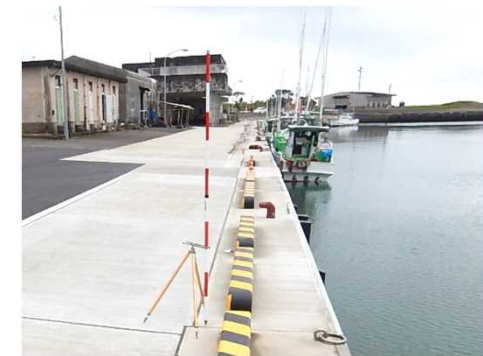
図21 物揚場の改修（野島漁港）
