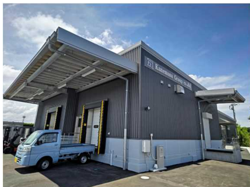
図9 HACCP対応の施設整備
