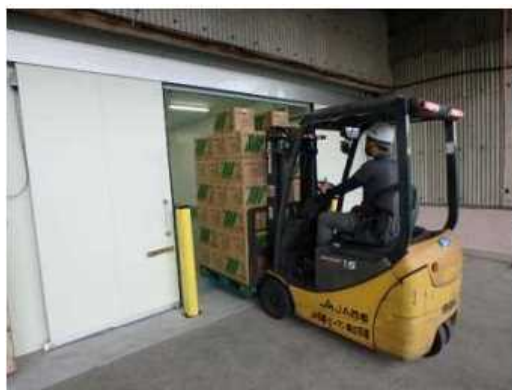
図14 冷蔵施設の改修
