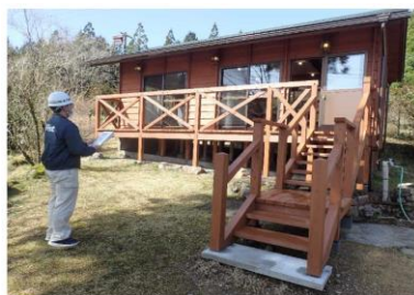
コテージの改修
