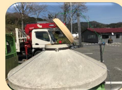
滑車式遠隔開閉タンク蓋
