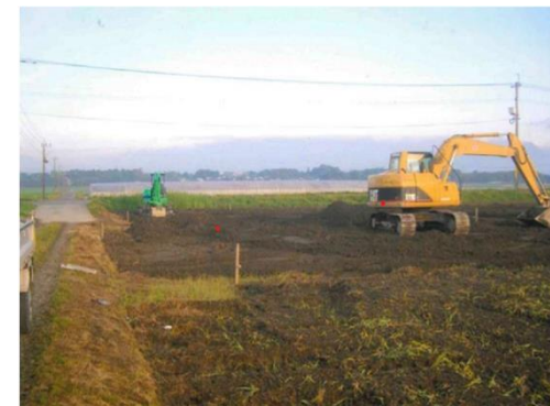
畦畔除去・整地工
