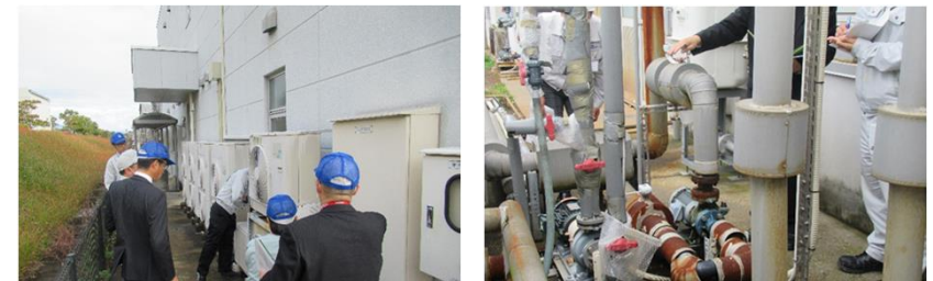
省エネ診断（現場調査）
