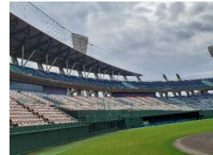
サンマリンスタージアム 屋根改修
