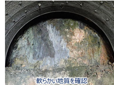
トンネル掘削断面状況
