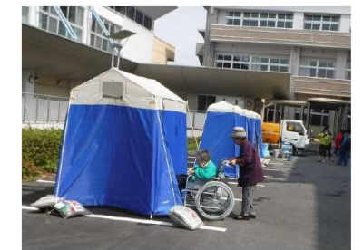
マンホールトイレ
