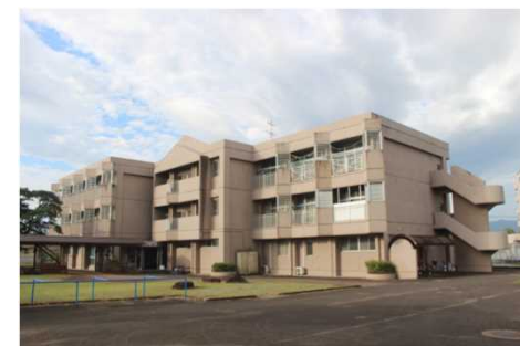
【県消防学校学生寮】
