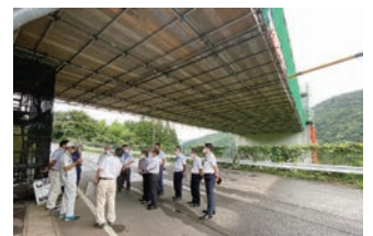
一般国道218号干支大橋(延岡市)
