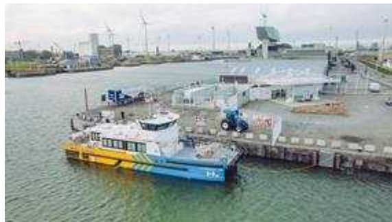
図 8: 水素ステーション
