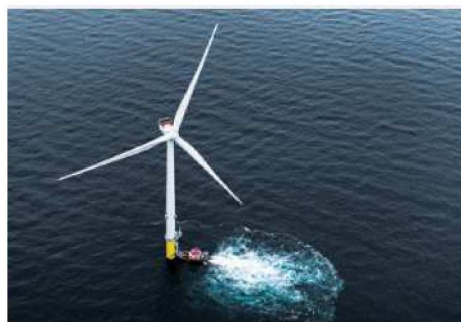
写真提供：Vestas Wind Systems A/S
