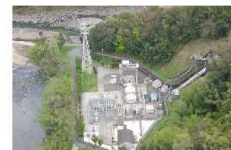
水力発電事業：新竹田発電所
