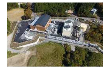
地熱発電事業：大岳発電所
