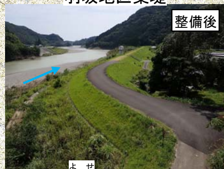
よせ 余瀬地区築堤
