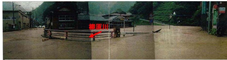
平成 9 年 9 月の被害状況(諸塚地区)
