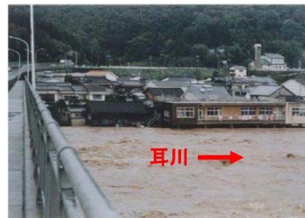
平成 16 年 8 月の被害状況(幸脇地区)
