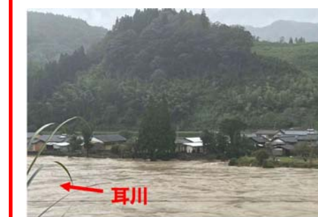
令和 4 年 9 月の被害状況(和田地区)
