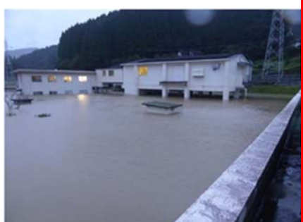
令和 4 年 9 月の被害状況(企業局浄水場)
