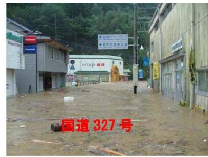
平成 16 年 8 月の被害状況(諸塚地区)
