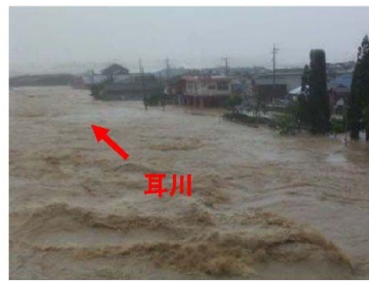
平成 17 年 9 月の被害状況(立縫地区)
