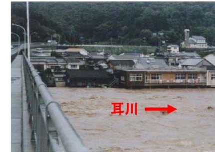
平成 16 年 8 月の被害状況(幸脇地区)
