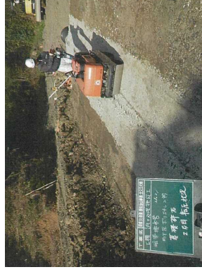
埋戻し状況（振動ローラー）
