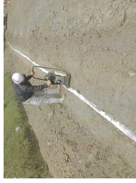
締めめ状況(暗渠部)
