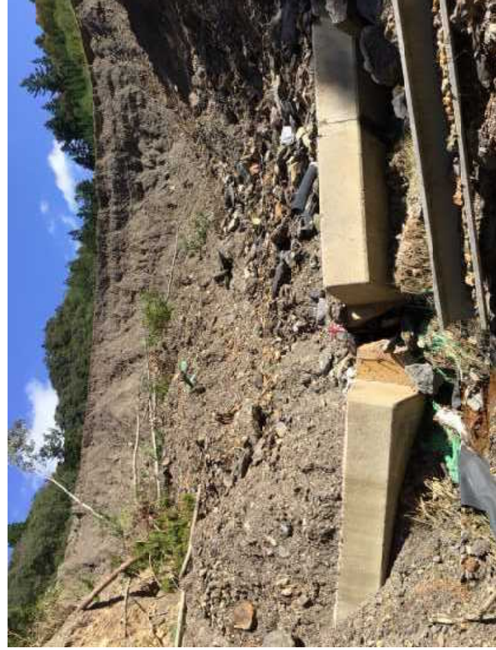
3 残土処理場崩壊状況(右岸側から撮影)
