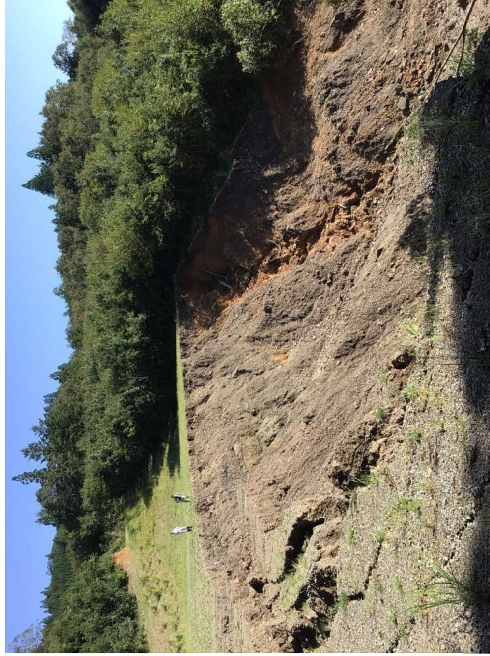
3 残土処理場崩壊状況(右岸側から撮影)
