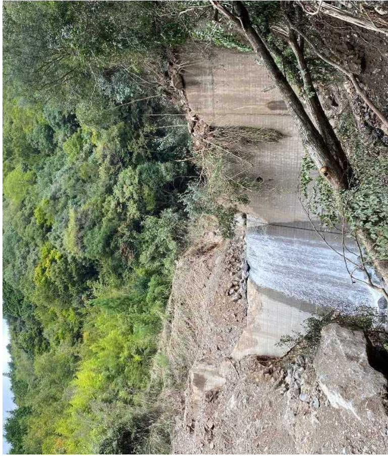
谷止工崩壊状況(工場上流部)
