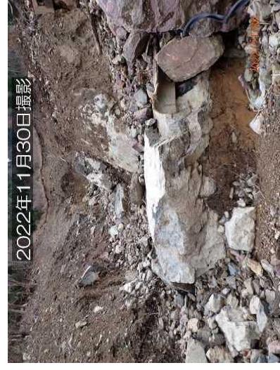
図 4.2-9 残土処理場崩壊箇所における地下水流出状況
