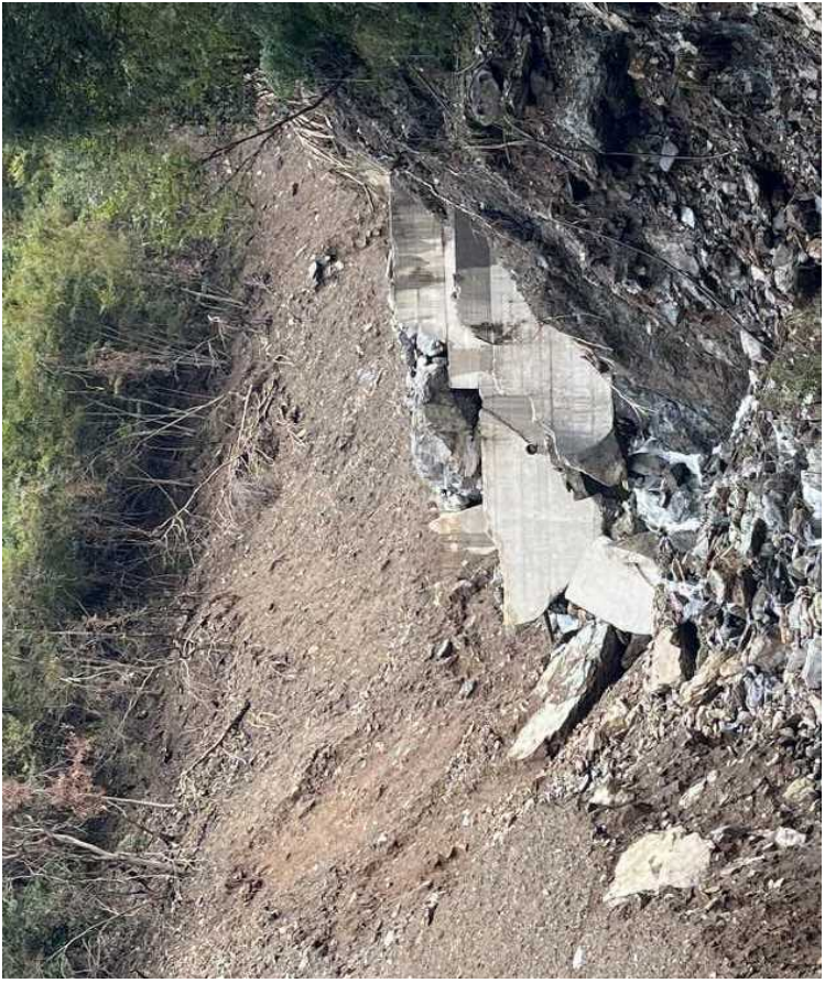
谷止工崩壊状況(工場上流部)
