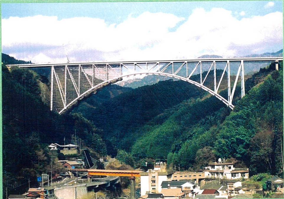
塗装工事のための足場を組んだ「青雲橋」
