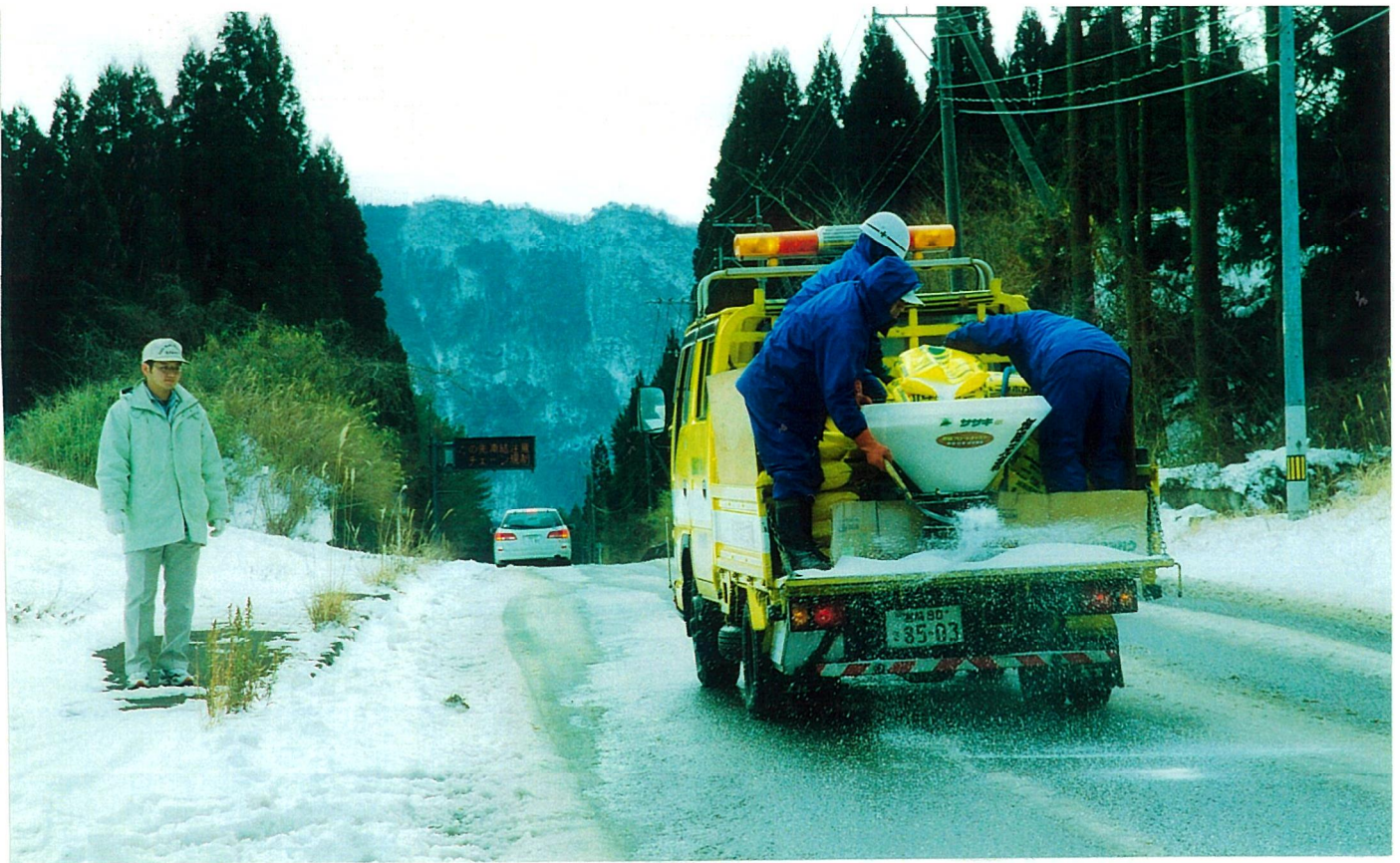
凍結した道路を溶かすため、昨年購入した農業用の散布機を使って、塩化カルシウムを散布する職員。 手作業で行っていた頃と比べ、20倍程度効率アップ。(写真は、国道265号の五ヶ瀬町鞍岡付近)
