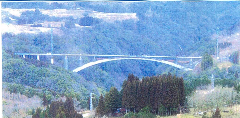
国見ヶ丘からみた建設中の「国見大橋」
