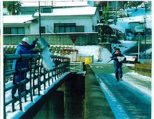
作業車の通らない細い道や橋などでは、手作業で除雪作業や融氷作業を行う。
