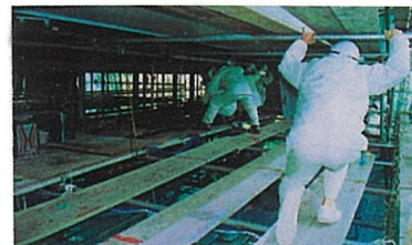
足場の組まれた現場を見学（青雲橋）
