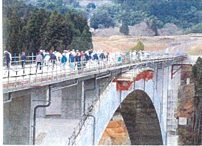
建設中の国見大橋。完成は今年11月(予定)
