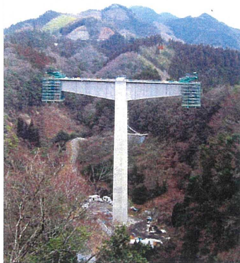
建設中の「夕日の里大橋」
