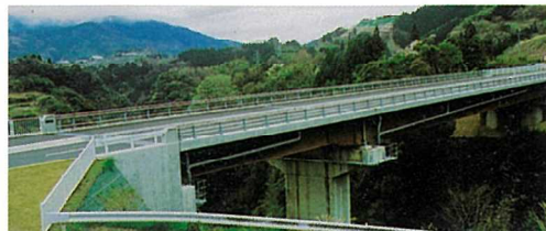
開通した県道日之影線「新古園橋」
