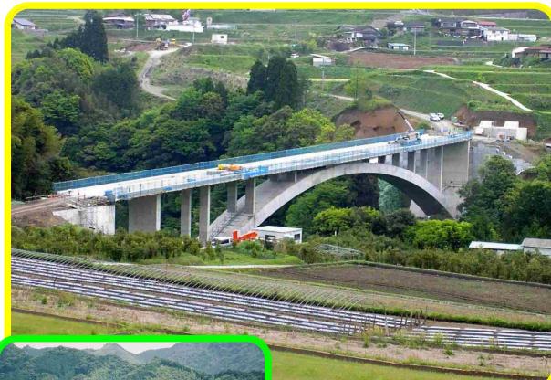
今年7月に完成予定の亀山城橋
