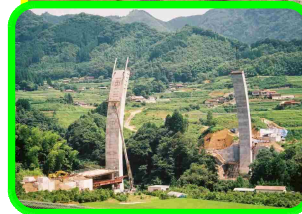
橋の架設には、ロアリング工法を採用（平成14年7月撮影）
