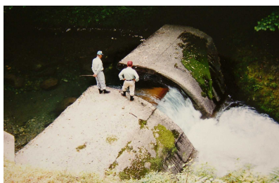
(管理状況)堰板が倒れるかを確認
