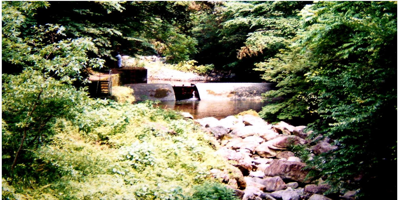
高千穂町岩戸の立宿頭首工 (堤長 16.0 m 堤高 2.6 m 受益面積 101 ha 管理者：高千穂土地改良区)
