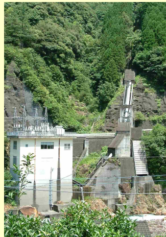
日之影町土地改良区が管理する「小水力発電所」
