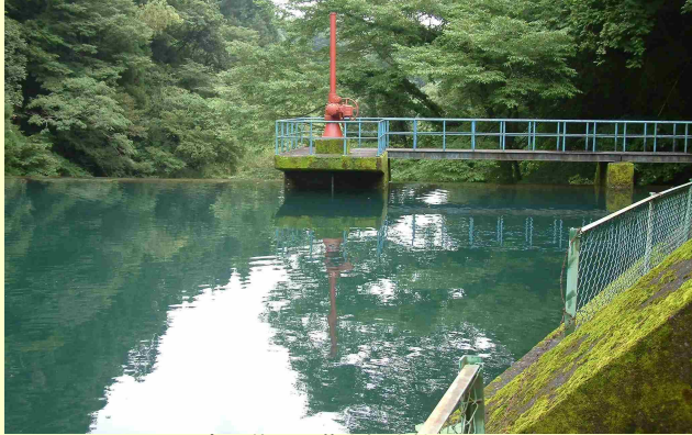
高千穂町の落立揚水機場
