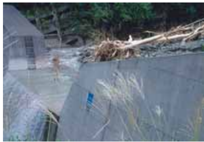
台風16号により満砂になった砂防ダム
