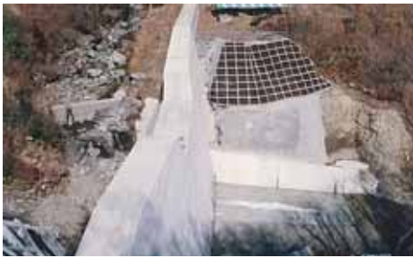
完成直後の砂防ダム
