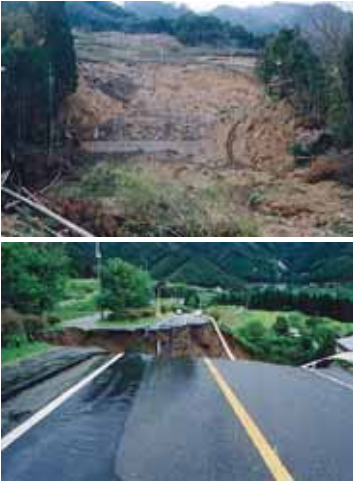
国道218号深角地区の道路崩壊の災害復旧前後の状況(平成12年度)
