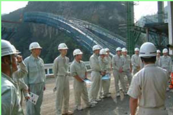
県道宇納間日之影線の新五ヶ瀬橋建設現場で、西臼杵支庁土木課の湯川主任技師から説明を受ける青年隊員
