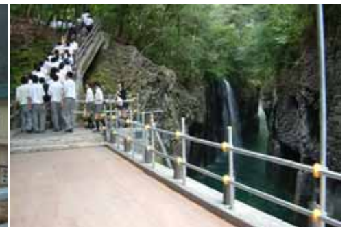
手すりが流されましたが、仮設手すり設置で復旧
