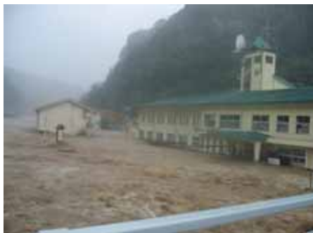
五ヶ瀬川の氾濫で日之影町役場は庁舎1階の机の高さまで浸水。役場が浸水したのは50年ぶり。
