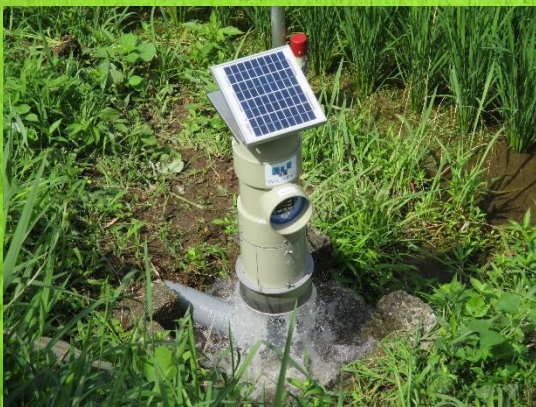
自動給水栓での給水の様子
