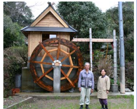
水車は松を使っており、直径3m。水車小屋には、水車の動力を利用した精米施設も設置。
