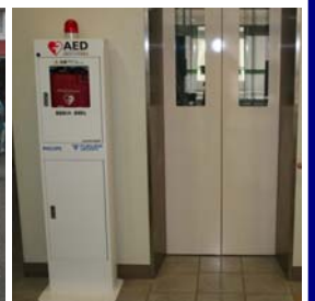
今年1月から支庁舎1階にAEDを設置しています。
