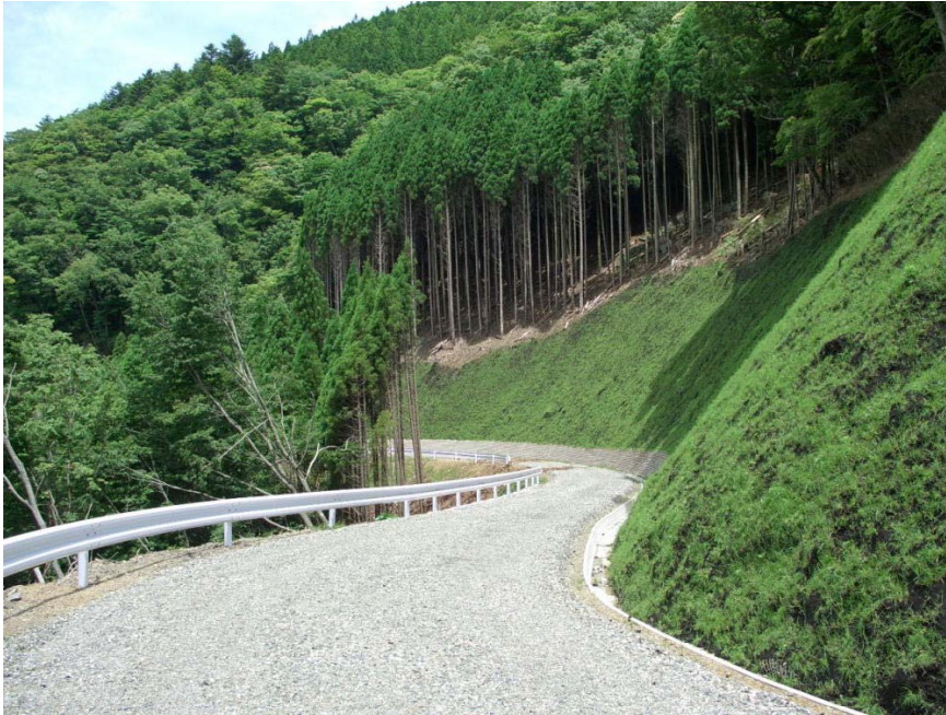
19年もの長い歳月を経て開通した林道
