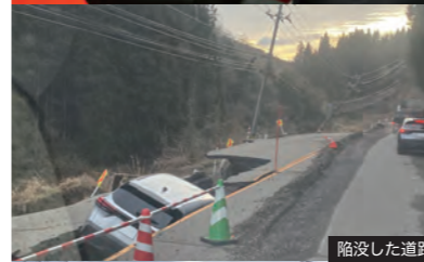
陥没した道路
