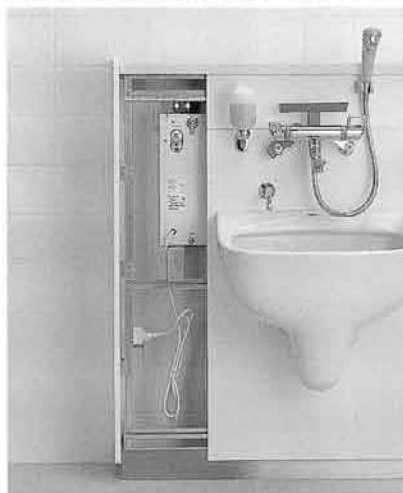
■ 電気温水器・点検口開口・ライニング
