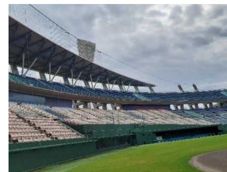
サンマリンスタージアム 屋根改修
