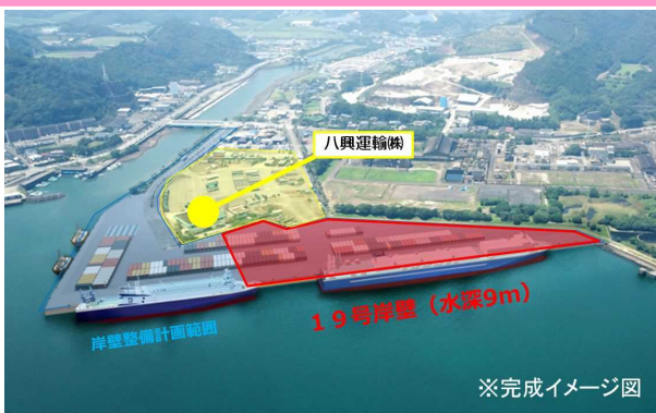
RORO岸壁と背後ふ頭用地を整備
