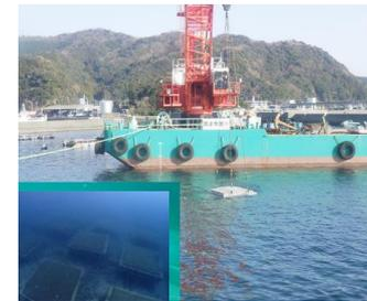
図3 藻場礁設置工事
