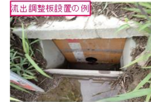
流出調整板設置の例
