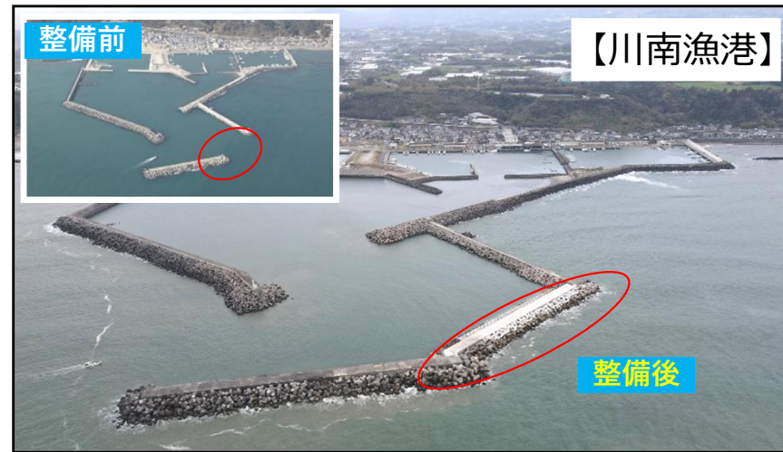
防波堤（新設、粘り強い化）
