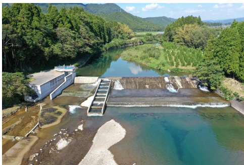
大島頭首工（串間市）
