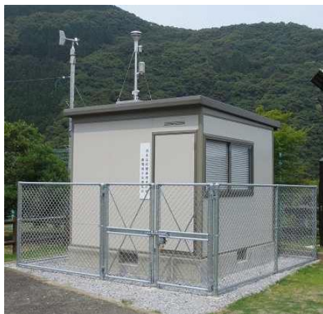
写真1 大気汚染常時監視測定局（西米良村）
